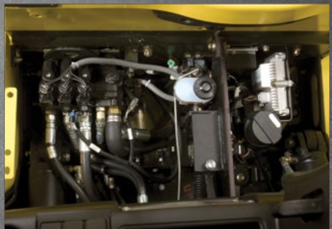
Acceso sin restricciones para el servicio
